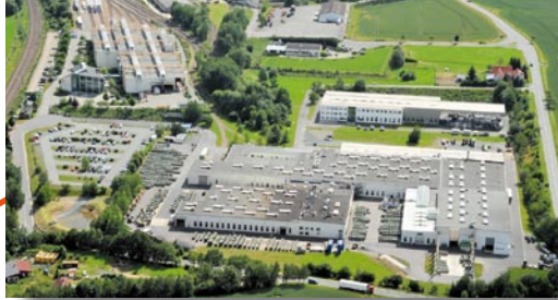
SGB Sächsisch-Bayerische Starkstrom-Gerätebau GmbH Neumark, D
