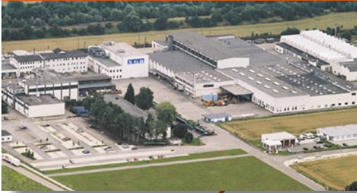
SGB Starkstrom-Gerätebau GmbH Regensburg, D
